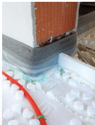
1) Dilatace stěn, dveřních otvorů, nestejných výšek, vytápěných a nevytápěných ploch
