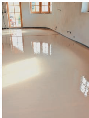
12) Konečný vzhled samonivelačního potěru
