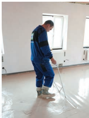
10) Odvzdušnění směsi pomocí hliníkové latě
