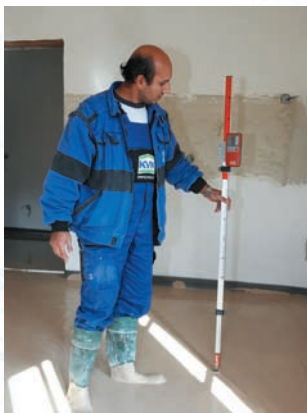
11) Přeměření správné výšky nalitého potěru
