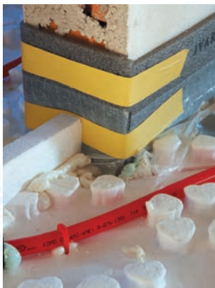
2) Položení izolace, separační fólie, připravení podlahového topení
