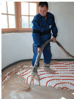
9) Doprava směsi pomocí čerpadla na místo a rozliti na připravenou plochu
